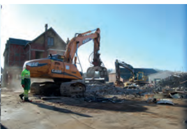
Démolition des bâtiments de la fonderie
