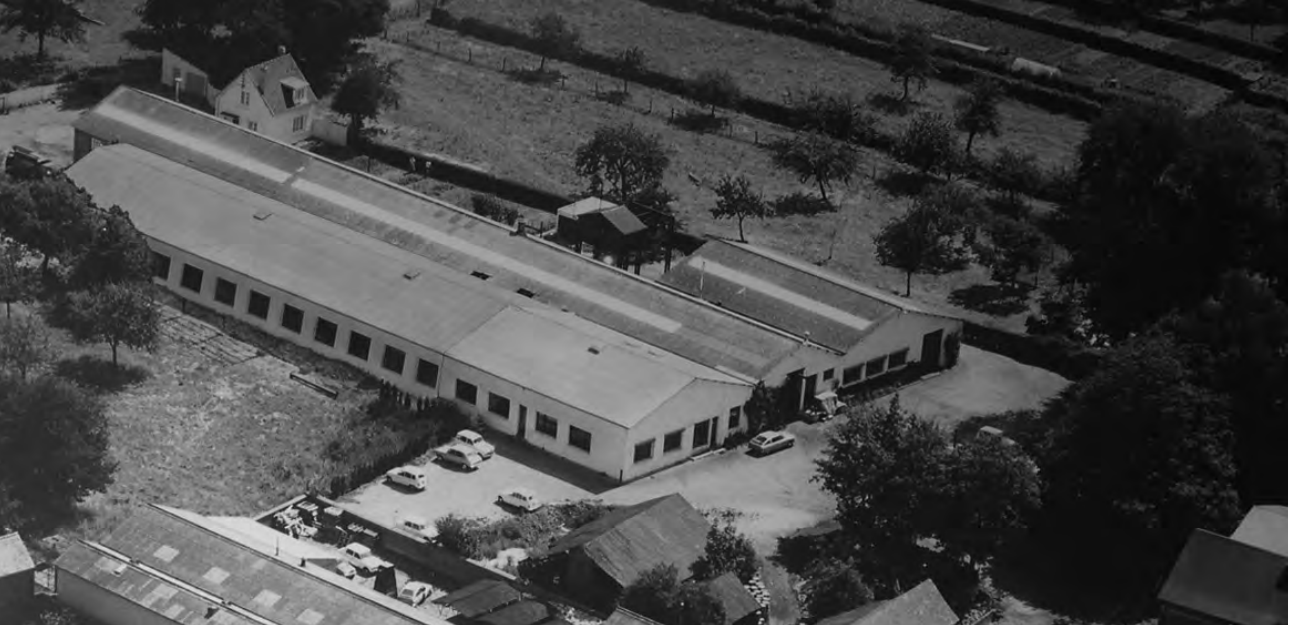
Nouvel atelier des tours multibroches en 1957
